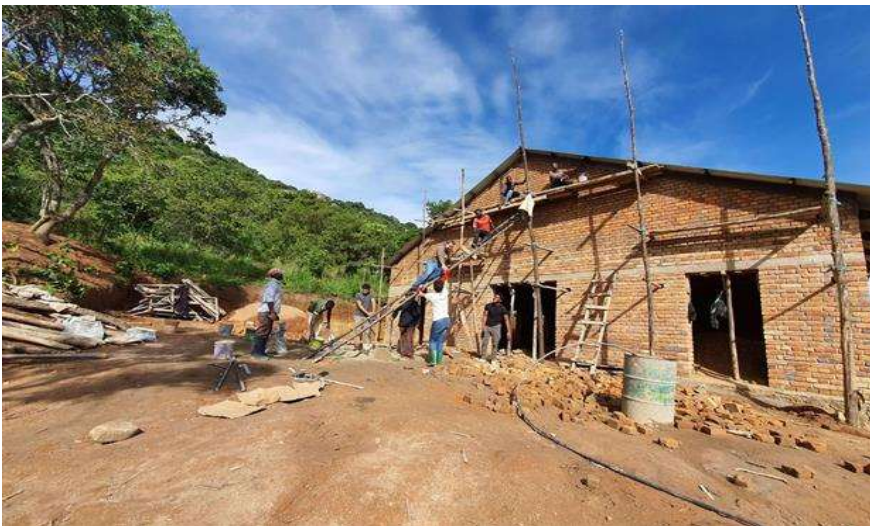
Federico Davoli in lavori di muratura
